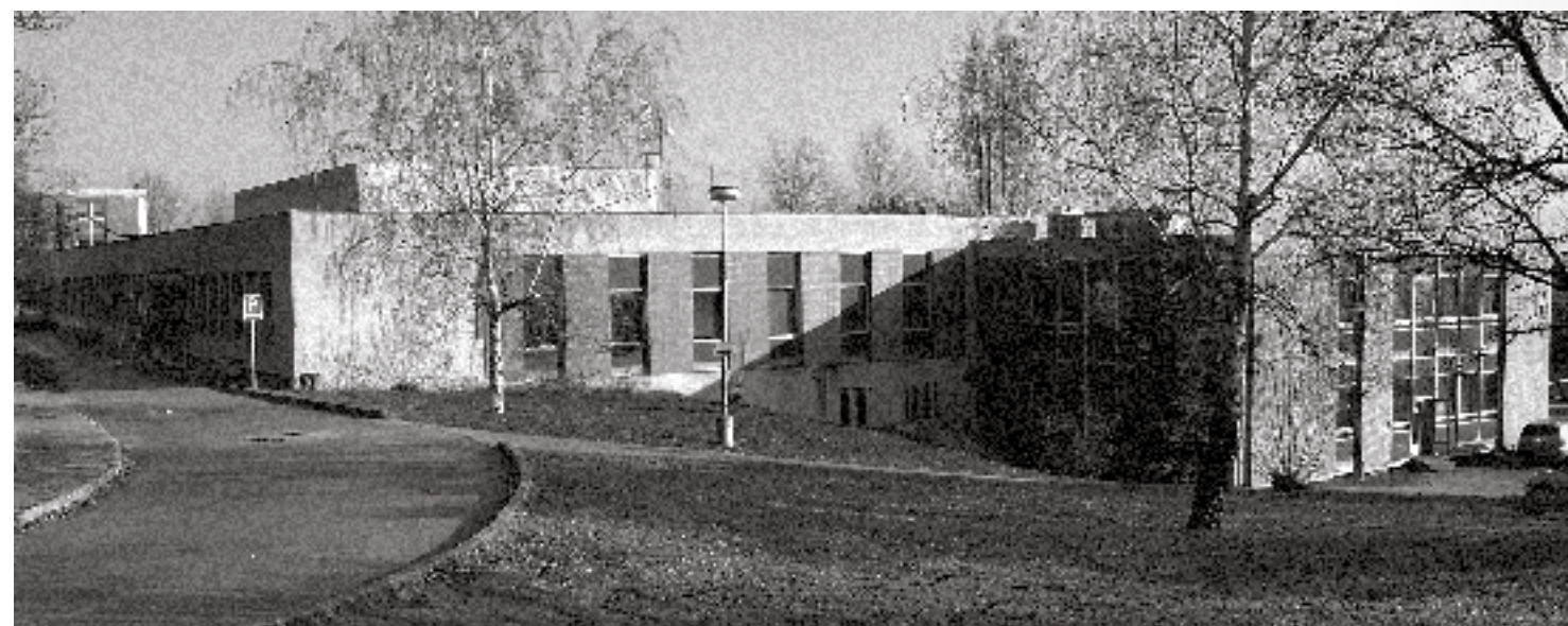
↓ Nové budovy Studia J. Trnky na Barrandově
